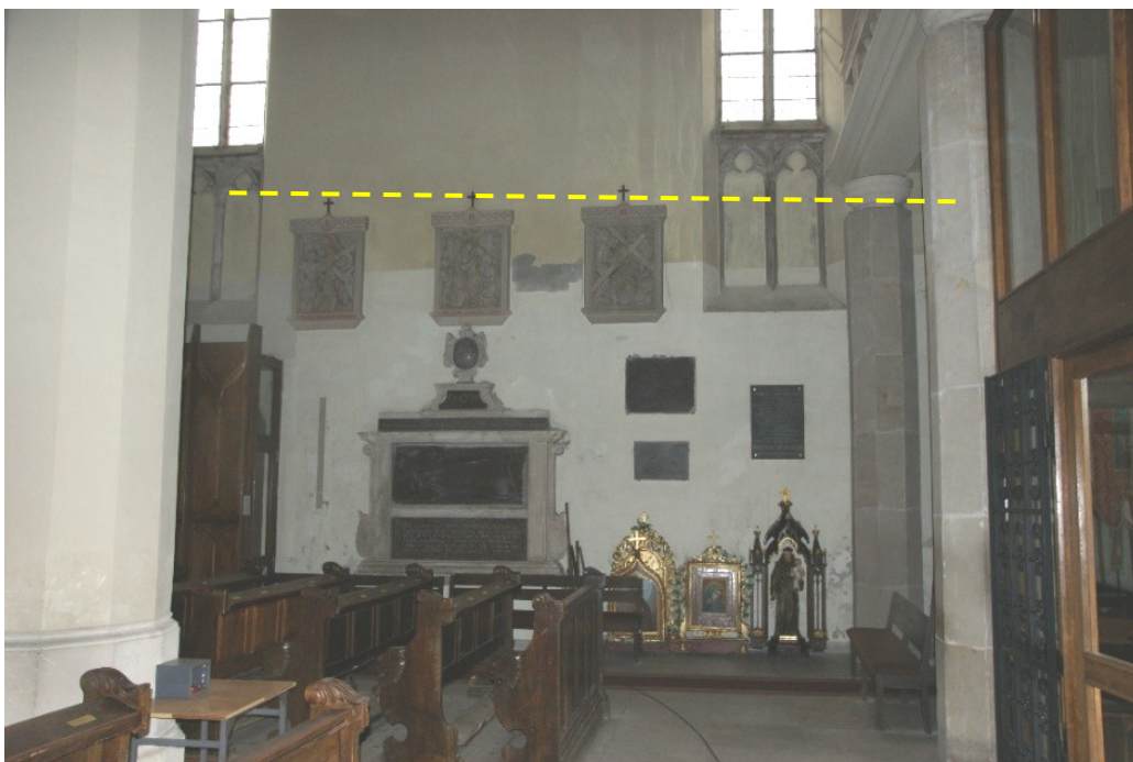
Fot. 31 Ściana południowa Kolegiaty – jasny kolor - widoczny poziom do jakiego ułożono tynki renowacyjne, żółta linią zaznaczono poziom widocznej destrukcji wyprawy.
