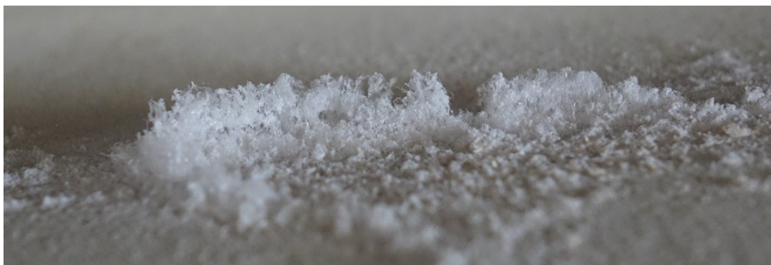
Fot. 39 Narośla soli budowlanych na powierzchni tynku renowacyjnego – wewnątrz Kolegiaty, ściana południowa.
