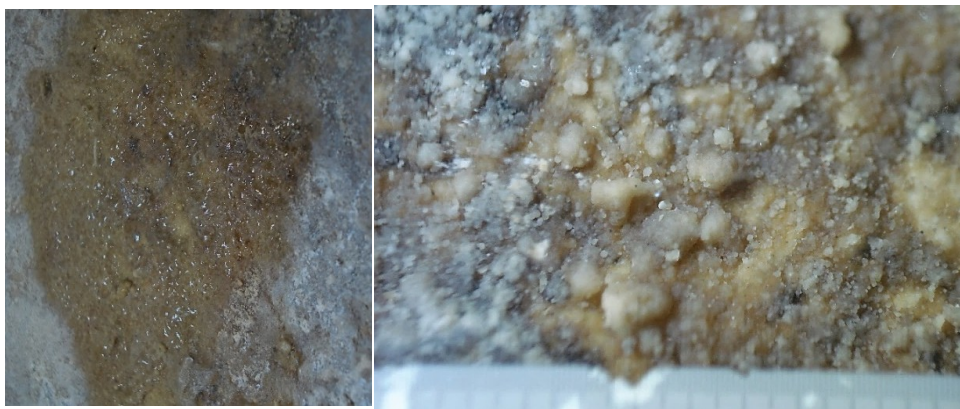
Fot. 46, 47 Po lewej: przecieki wody przez ciosy wapienne, widoczne krople wody w miejscu występowania przecieku. Po prawej: aktywny przeciek w powiększeniu (skala: podziałka „1” = 1 mm).
