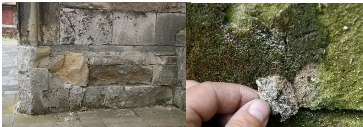
Fot. 9, 10 Po lewej: elewacja zachodnia – destrukcja ciosów wapiennych na cokole przypory. Po prawej: rozwój mchów na powierzchni kamiennych części cokołu.
