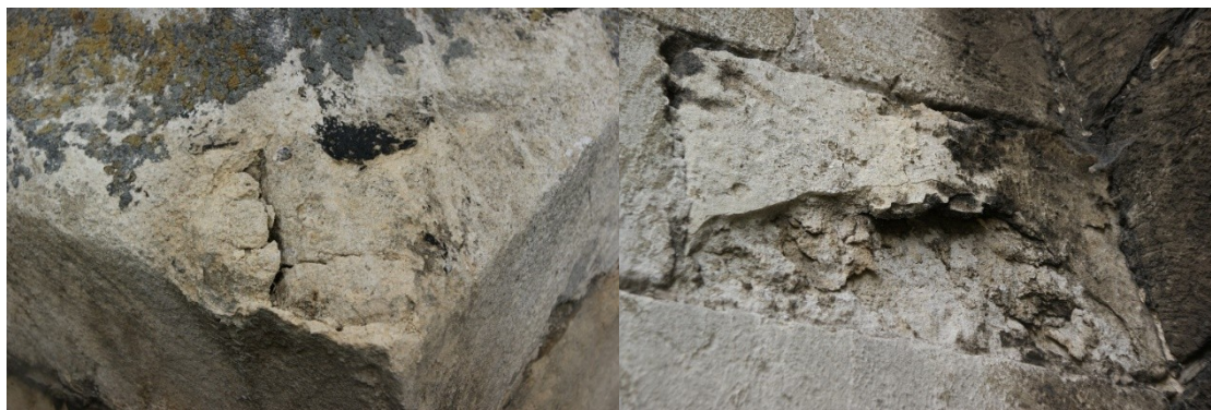
Fot. 17, 18 Porowata struktura ciosów kamiennych – różne fazy destrukcji mrozowej
