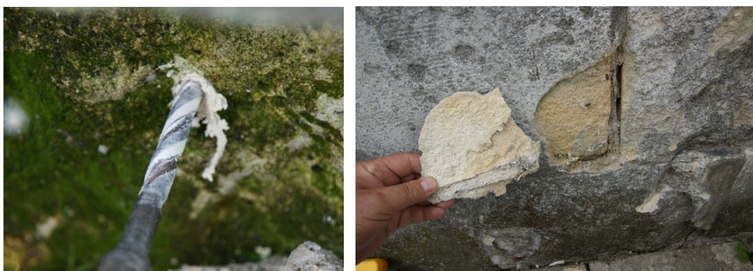
Fot. 24, 25 Po lewej: odwiert w wapieniu na cokole –mokry urobek na wiertle. Po prawej: odspojona zaprawa w miejscach wykonywania napraw cokołu – widoczny fragment zaprawy naprawczej wraz ze spoiną.
