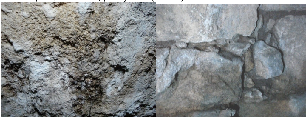
Fot. 40, 41 Narośla soli budowlanych na powierzchni ciosów wapiennych, po prawej: przebarwione, zawilgocone spoiny.
