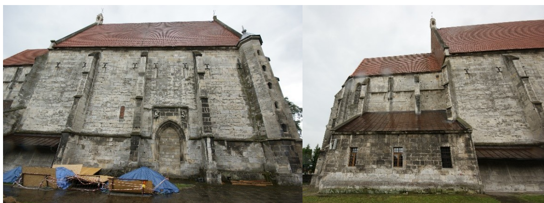
Fot. 3, 4 Kolegiata: po lewej – elewacja północna, po prawej – elewacja północna, prezbiterium. Przebarwienia i destrukcja ciosów wapiennych.
