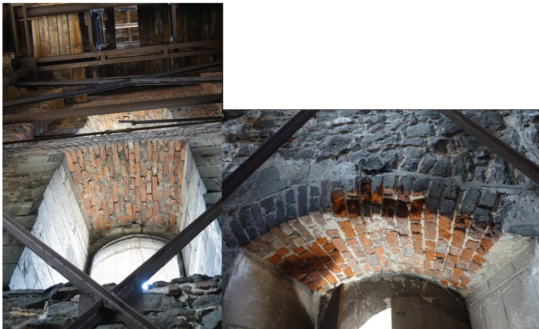
Fot. 59, 60 Wnętrze Dzwonnicy. Po lewej: fragment wzmocnień konstrukcji, po prawej: zbliżenie na nadproże łukowe okna pierwszej kondygnacji – brak przeniesienia rysy występującej na ciosach zewnętrznych.
