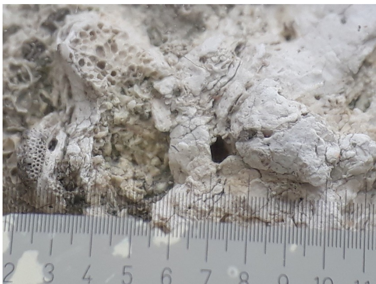
Fot. 82 Ściany Kolegiaty: skala wysoleń na powierzchni ciosów, powiększenie – skala 1mm.
