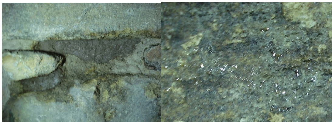
Fot. 48, 49 Aktywne przecieki przez watek kamienny – zawilgocone spoiny. Po prawej: przecieki wody przez ciosy wapienne, widoczne krople wody w miejscu występowania przecieku
