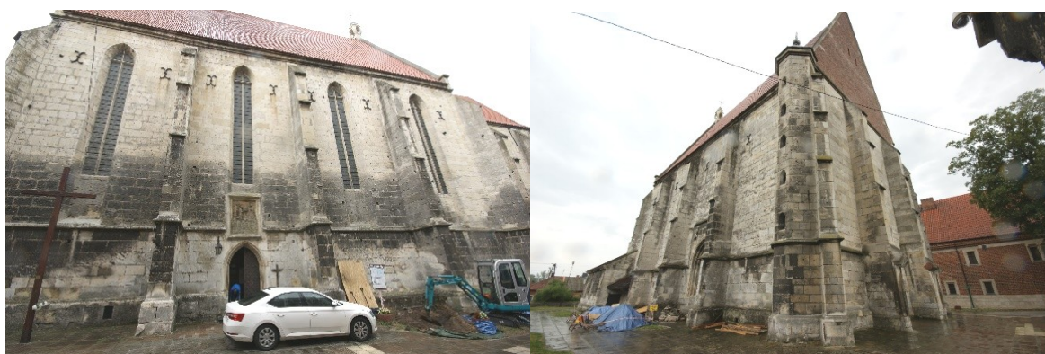
Fot. 7, 8 Kolegiata: prezbiterium i elewacja południowa. Przebarwienia i destrukcja ciosów wapiennych.
