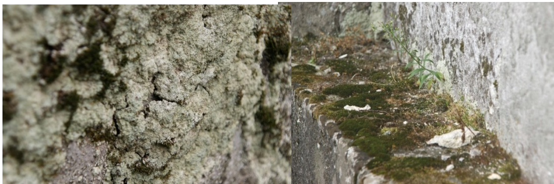
Fot. 11, 12 Po lewej: cokół Kolegiaty – stopień destrukcji mrozowej ciosów kamiennych, nawarstwienia roślinne. Po prawej: rozwój mchów i roślinności na gzymsie cokołowym po stronie północnej.
