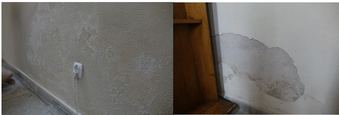
Fot. 37, 38 Ściany wewnętrzne Kolegiaty: różne stadia destrukcji tynków renowacyjnych. Po prawej – odspojona, skorodowana warstwa szpachlówki renowacyjnej, tynk renowacyjny – całkowita akumulacja soli w strukturze tynku renowacyjnego, wyprawa odspojona od podłoża.
