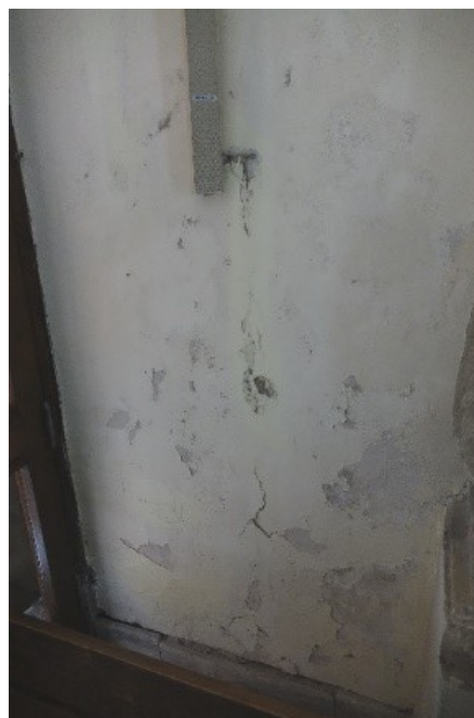
Fot. 33, 34 Ściany wewnętrzne Kolegiaty: różne stadia destrukcji tynków renowacyjnych.
