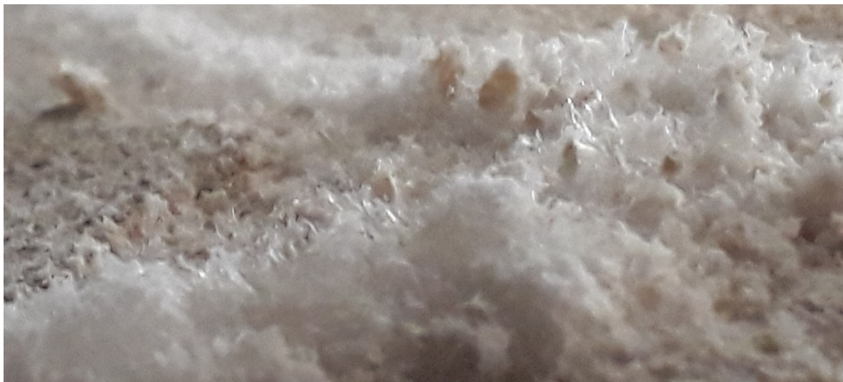
Fot. 83 Narośla soli budowlanych na powierzchni tynków renowacyjnych na południowej ścianie Kolegiaty.
