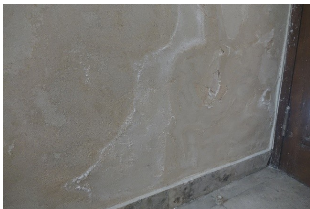
Fot. 32 Ściana północna Kolegiaty – jasnym kolor - widoczny poziom do jakiego ułożono tynki renowacyjne, żółta linią zaznaczono poziom widocznej destrukcji wyprawy.
