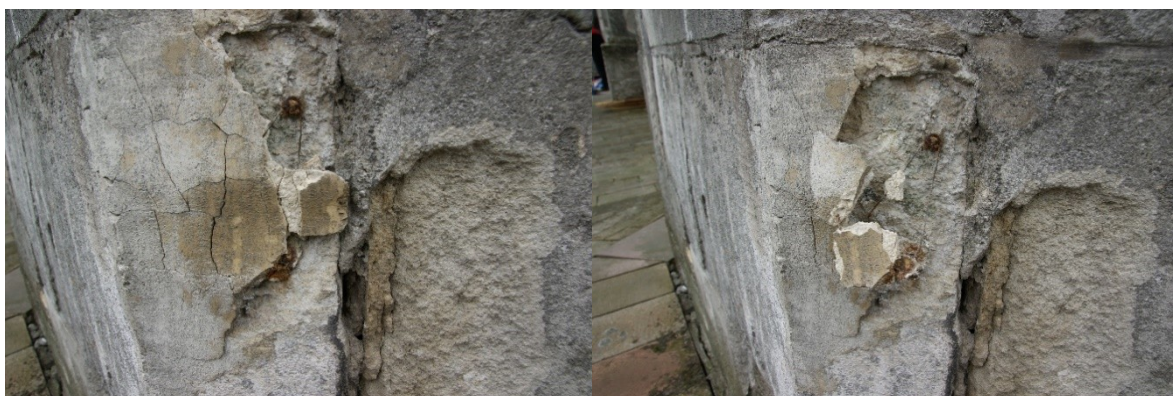
Fot. 28, 29 Narożnik północno-zachodni: Od lewej – stopień destrukcji w miejscu wykonanych napraw, po prawej – sposób ich wykonania: za adhezję zaprawy „odpowiada” drut wiązałkowy obwiązany wokół śrub łączników mechanicznych.
