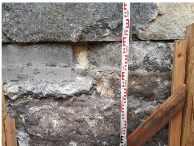
Fot. 62 Dzwonnica, ściana wschodnia, odkrywka OD1: widoczna destrukcja ciosów wapiennych powyżej poziomu opaski oraz wysolenia na odsłoniętym, wysychającym fragmencie ściany fundamentowej.
