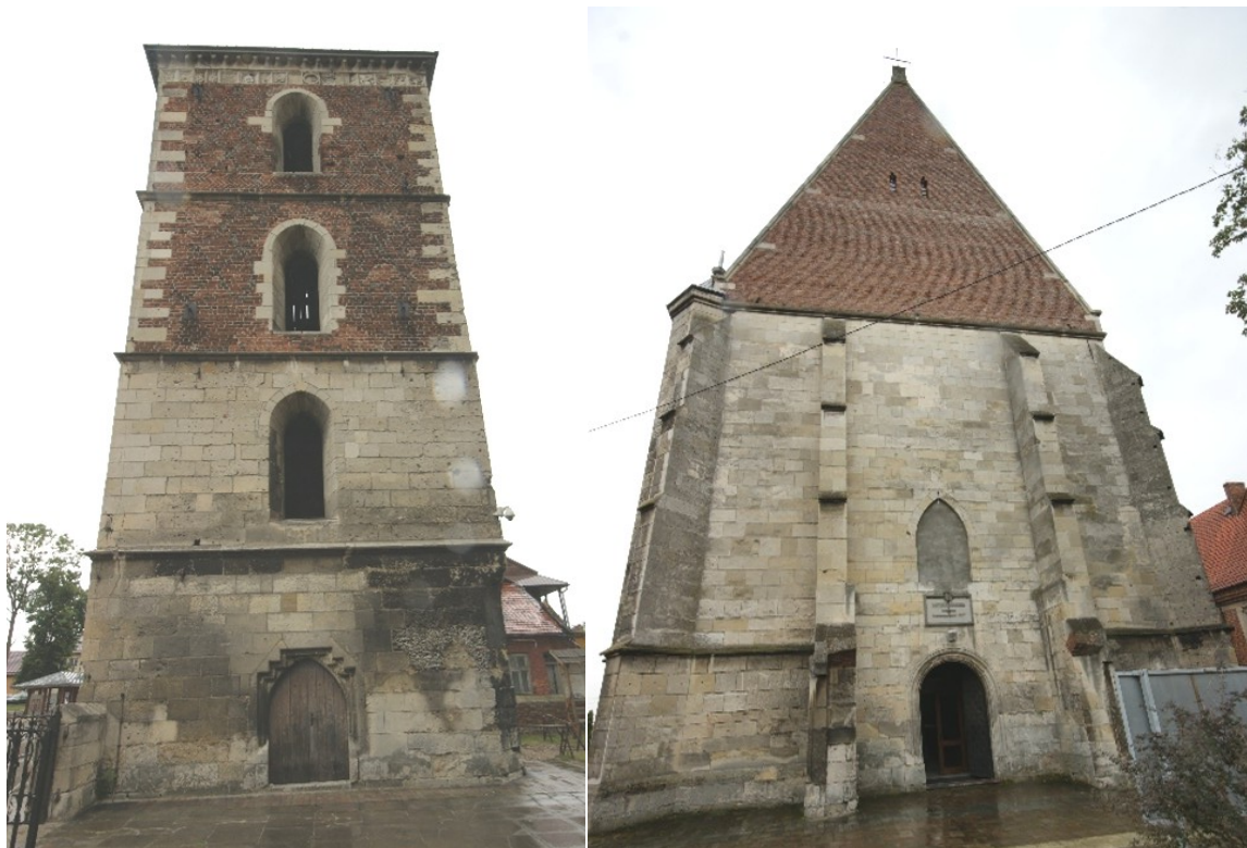
Fot. 1, 2 Po lewej: Dzwonnica. Elewacja południowa, po prawej: Kolegiata. Kruchta, elewacja zachodnia. Przebarwienia i destrukcja ciosów wapiennych.
