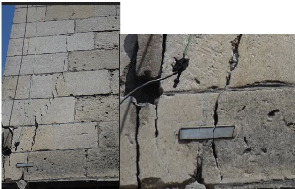
Fot. 61 Przebieg rysy w narożniku południowo-zachodnim. Rysa przeniesiona na szklana plombę.
