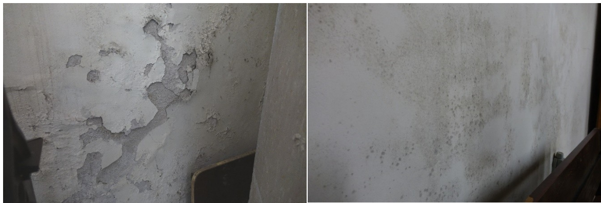
Fot. 35, 36 Ściany wewnętrzne Kolegiaty: różne stadia destrukcji tynków renowacyjnych. Po prawej – porażenie powierzchni wypraw tynkarskich przez grzyby rozkładu pleśniowego.
