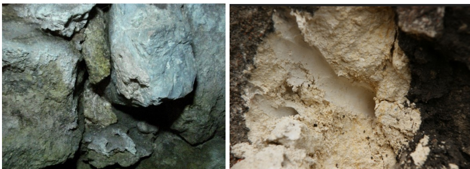
Fot. 42, 43 Po lewej: przebarwione, zawilgocone spoiny. Po prawej: silnie zawilgocone, bardzo miękkie spoiny.
