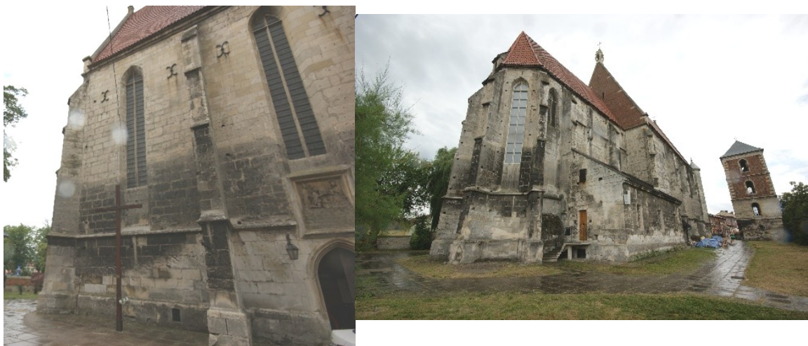
Fot. 5, 6 Kolegiata: prezbiterium, elewacja wschodnia. Przebarwienia i destrukcja ciosów wapiennych.
