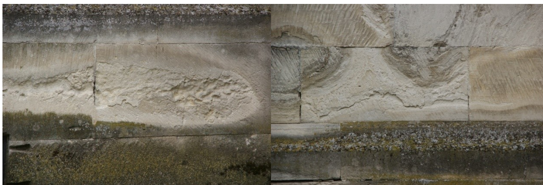
Fot. 19, 20 Kolegiata, elewacja południowa – powierzchniowa korozja ciosów wapiennych o wysokiej nasiąkliwości.
