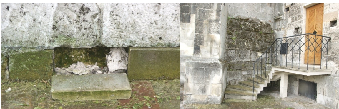
Fot. 13, 14 Kolegiata, elewacja północna. Po lewej: odpadający cios na cokole zakrystii, destrukcja zaprawy, powierzchniowy rozwój mchów. Po prawej: przebarwienia ciosów kamiennych przy wejściu do zakrystii.
