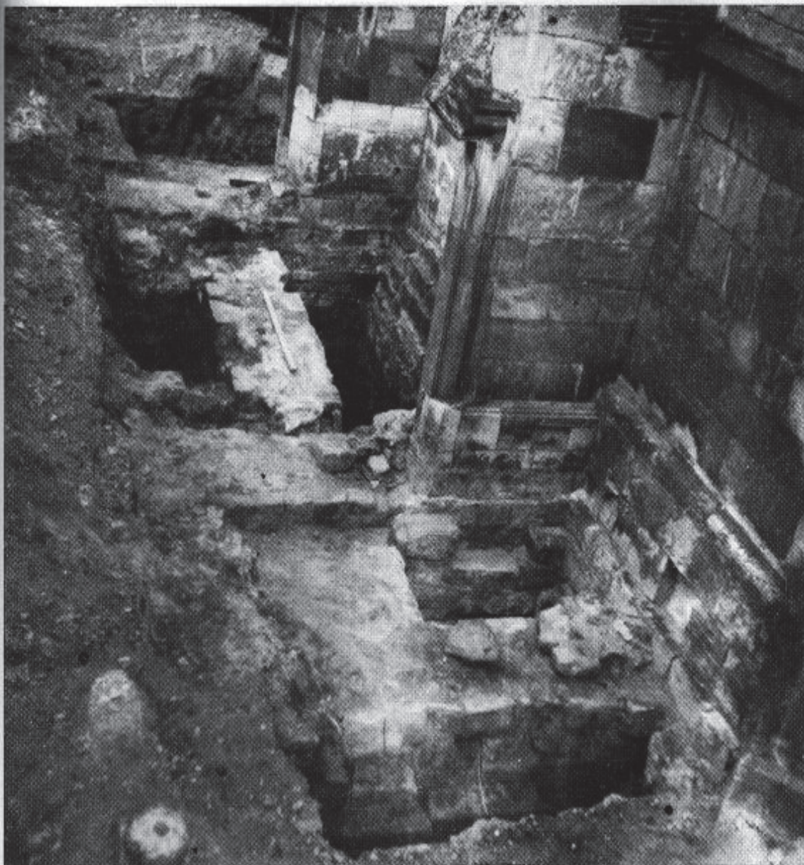
Ryc. 13. Kolegiata wiślicka. Kościół romański II. Mury części cokołowej fasady zachodniej przecięte murami fasady istniejącego kościoła projektowanej przez A. Szyszko-Bohusza. Fot. E. Buczek 1958
