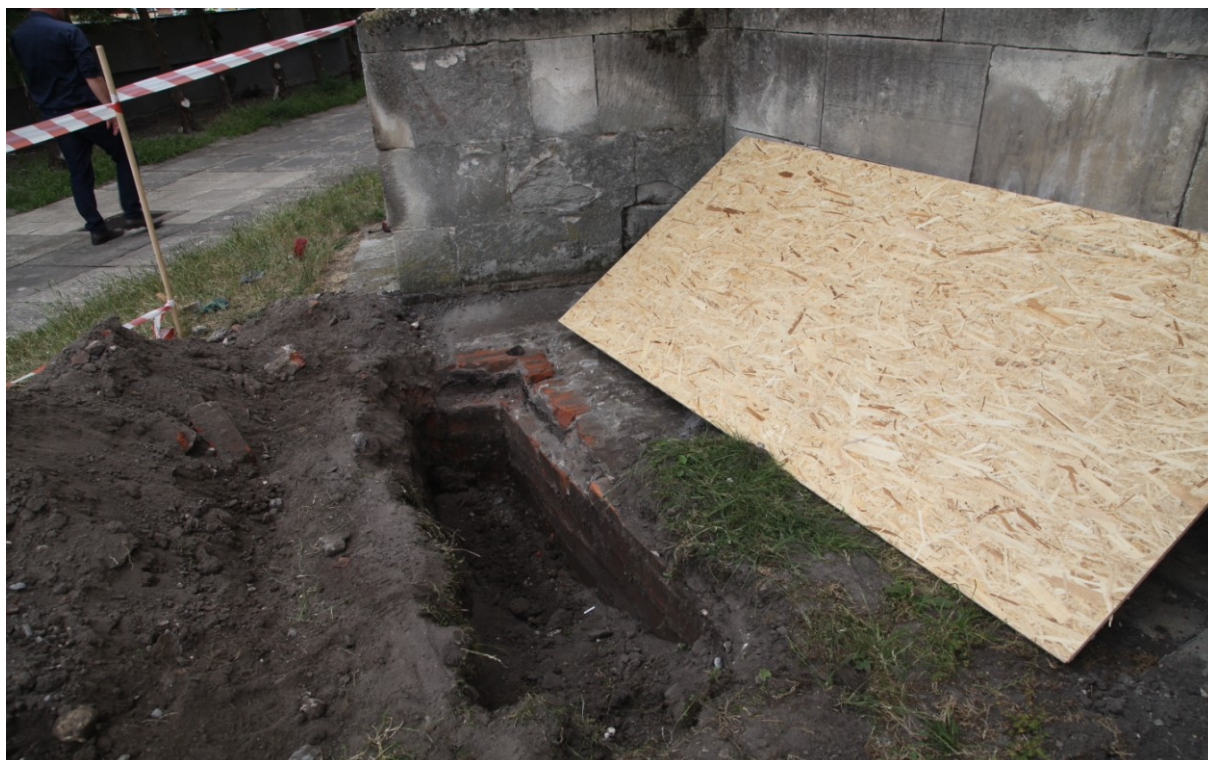
Widok na sondaż 3, w momencie odsłonięcia oporowego muru ceglanego -widok w kierunku południowym.
