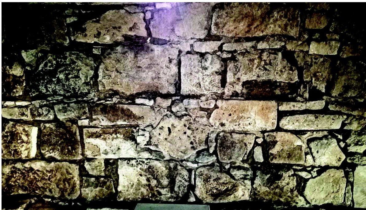
Fragment muru piwnicy, zawilgocone fugi, wykwyty na powierzchni bloków, pola zasiedlone glonami.
