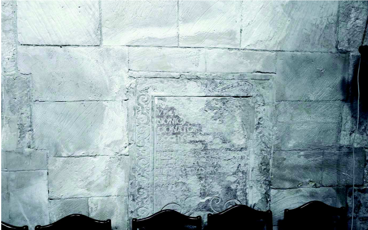
Procesy wietrzenia epitafium oraz kamiennego budulca ścian Kolegiaty w strefie zmiennego stopnia zawilgocenia.
