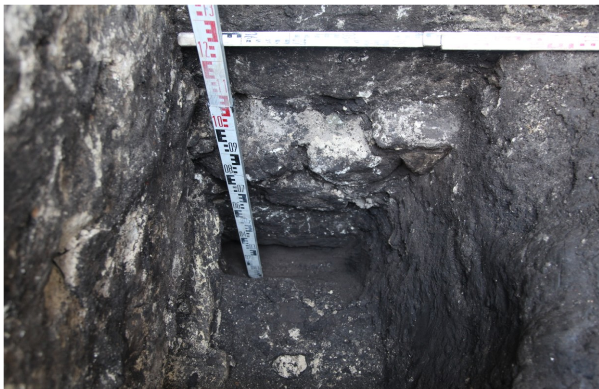
Zbliżenie na stopę fundamentową oraz odsadzkę kolegiaty - widok w kierunku południowym.
