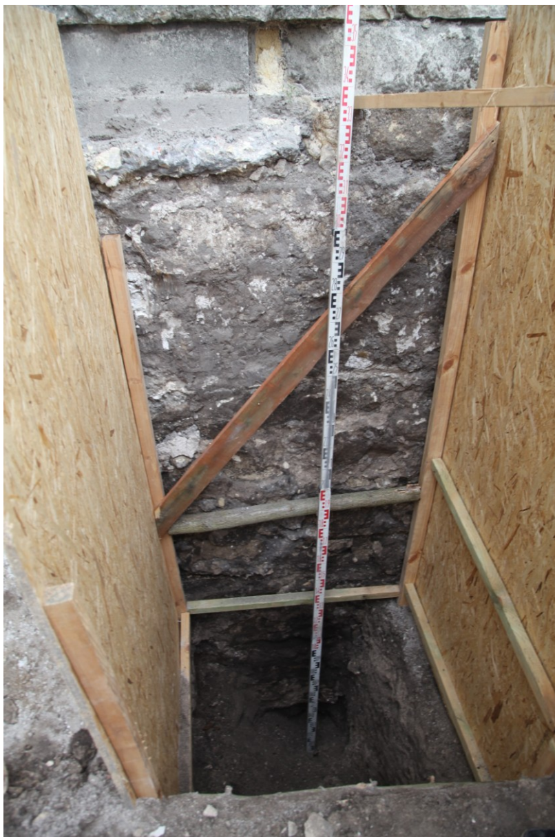
Widok na profil fundamentu dzwonnicy, w momencie uzyskania głębokości jego posadowienia (widok kierunku zachodnim)
