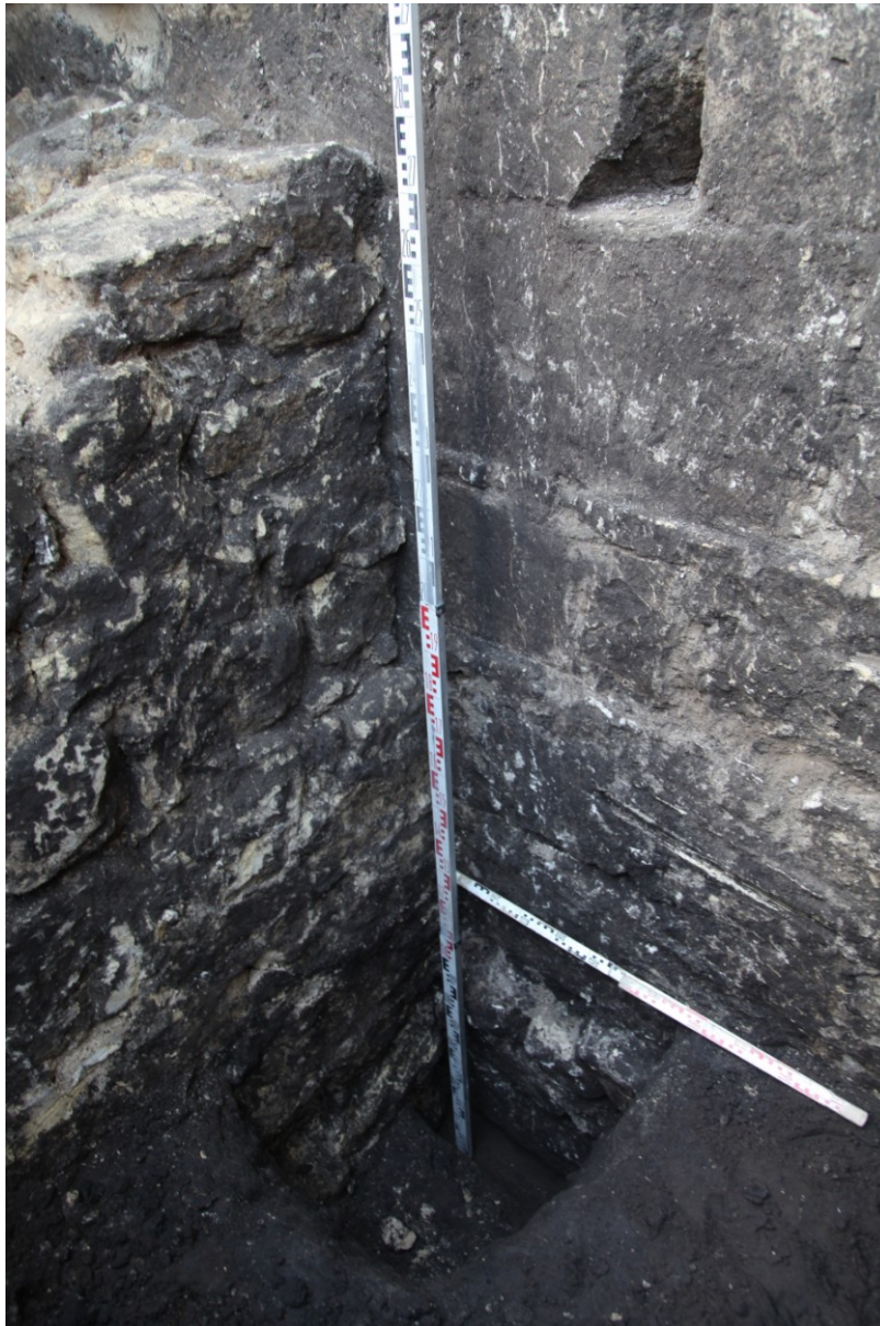
Widok na lico fundamentu kolegiaty oraz muru dostawionego i nastawionego na odsadzkę fundamentu kolegiaty – widok w kierunku południowi-wschodni,
